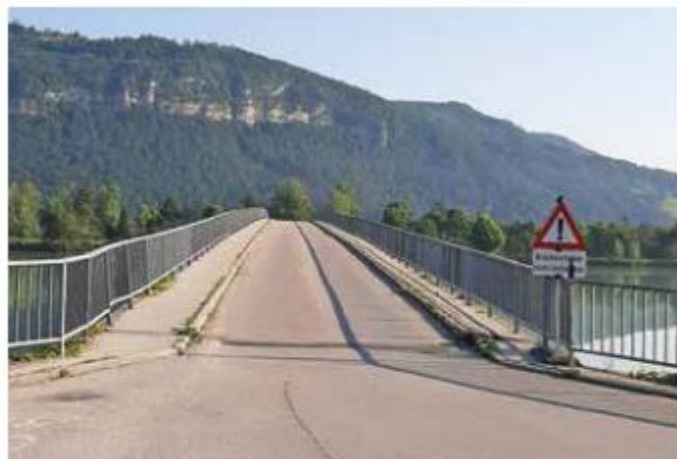
Im Herbst wird die ÖDK Brücke im Rosental gesperrt
