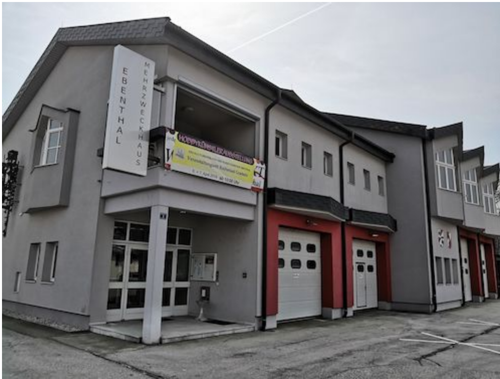
Auch im Kulturhaus Gradnitz wird der Saal saniert Marktgemeinde Ebenthal
