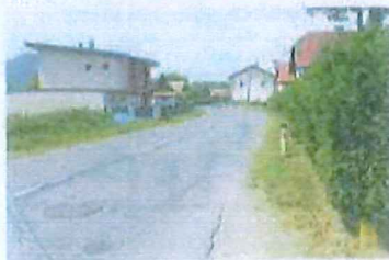
Hier fehlt noch der Gehweg-Lückenschluss
