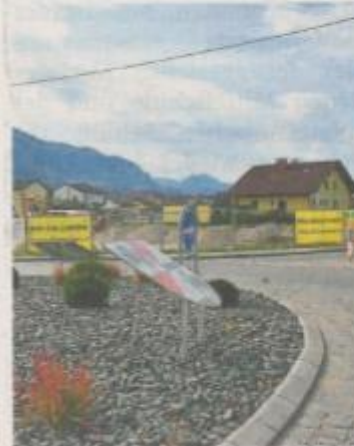
Beim Kreisverkehr vor Gurnitz entsteht der neue Adeg
