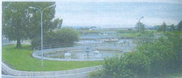
Die Kläranlage am Südring ist v. a. im Sommer am Limit, nun wird Kapazitätsbedarf für Neubau oder Sanierung geprüft Stadtpresse/Burgstaller
