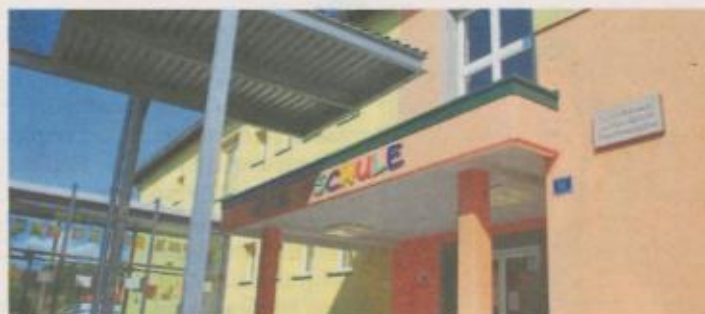
Ein Teil der Volksschule Ebenthal wird neu gebaut, die restliche Schule generalsaniert
