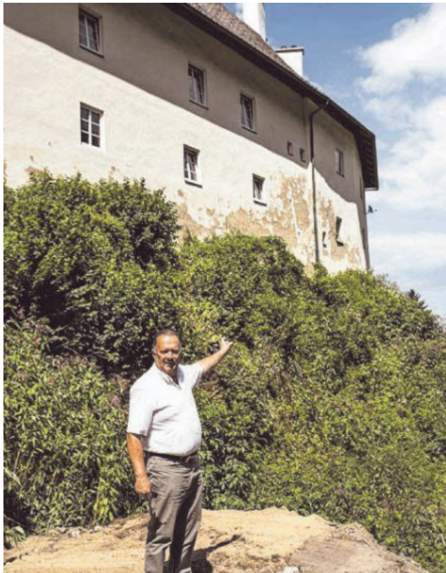
Der Ebenthaler Bürgermeister Franz Felsberger (links) hilft, wo er kann: „Die Gemeinde liefert Aushubmaterial zum Aufschütten“ TRAUSNIG (2)
